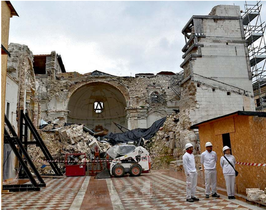
L'interno della Basilica dedicata al santo patrono dell'Europa devastata dal sisma
